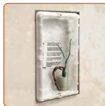
Utilisation d'une paire de fils existante pour connecter le nouveau poste extérieur
