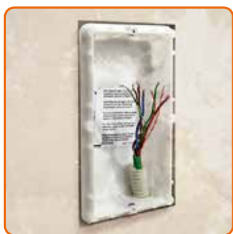
Suppression du poste extérieur existant
