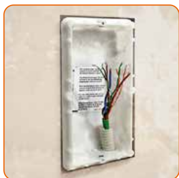
Suppression du poste extérieur existant
